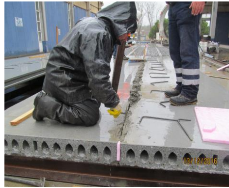
b- Aranın harçla doldurulması
