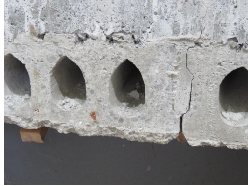
b) ÖBD elemanları birleşim kesitinde çatlak
